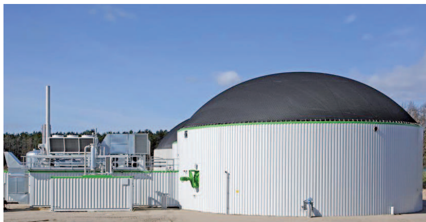
Установка для производства биогаза
